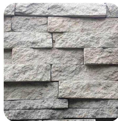
MURO EXTERIOR EN FACHADA FRONTAL, CON RECUBRIMIENTO PIEDRA GALARZA DE LARGOS VARIABLES
