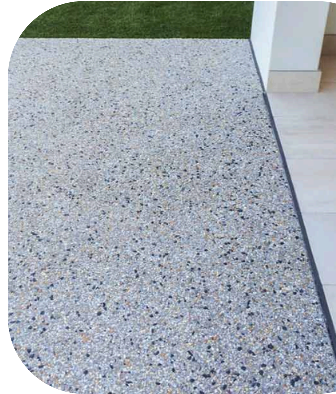
ACABADO EXTERIOR PARA ANDADORES Y TERRAZAS. CONCRETO LAVADO CON AGREGADO DE BASALTO
